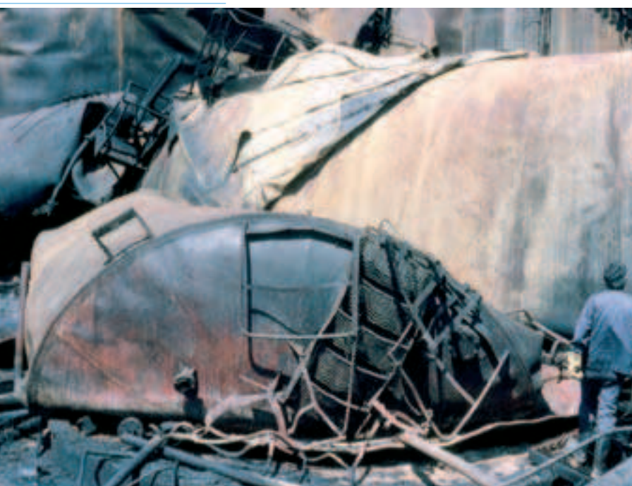
Fig. 11 - Bac d'hydrocarbure après une explosion interne
